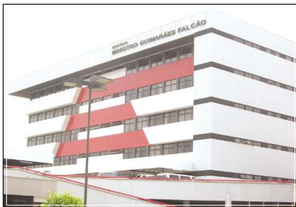
De linhas modernas, edifício é a nova sede das varas da capital
